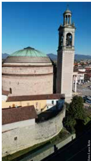
Veduta del castello e della chiesa
